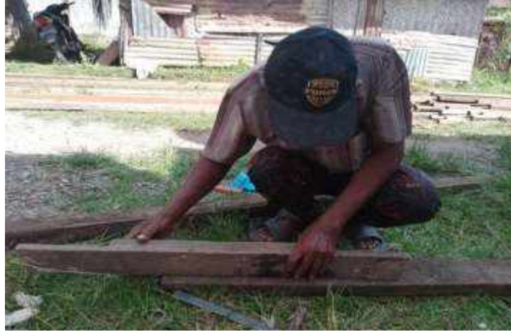
Gambar 4. 2 Membuat Tiang Penyangga
