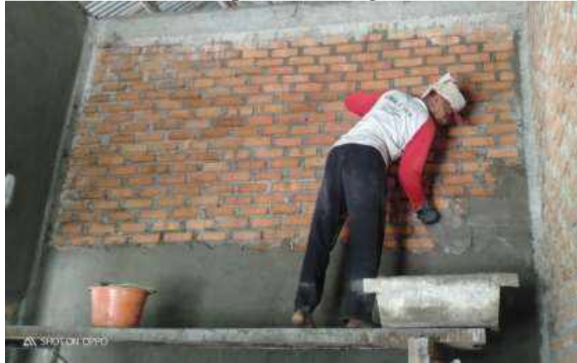
Gambar 4.3 Memplester Dinding
