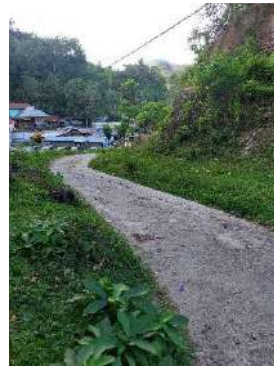
Gambar 4.10 Akses jalan yang rusak
