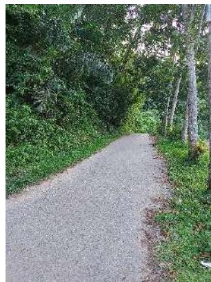
Gambar 4.11 Akses jalan yang sempit
