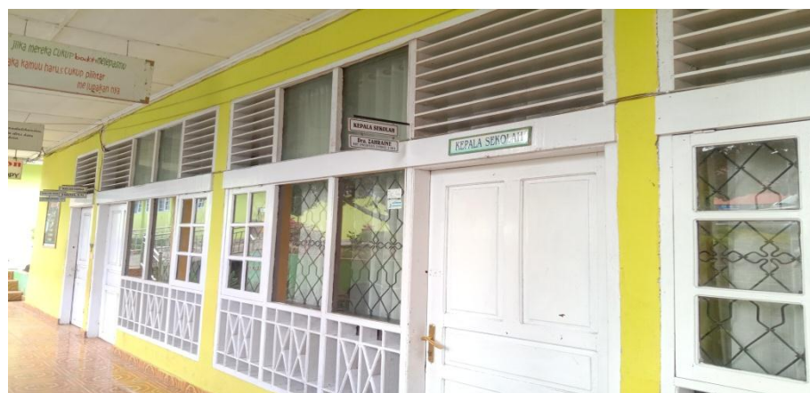
Gambar 14. Foto Ruang Kepala Sekolah SMA N 1 Sungayang
